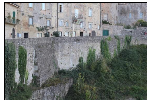
Fig. 31 – Vista della sezione 22 notevole presenza di vegetazione
