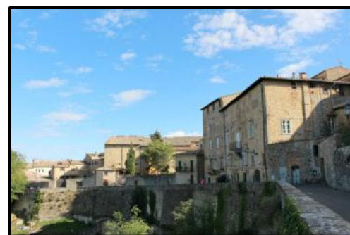
Fig. 30 – Vista della sezione 21: a monte strada asfaltata ed edifici, a valle anfiteatro romano
