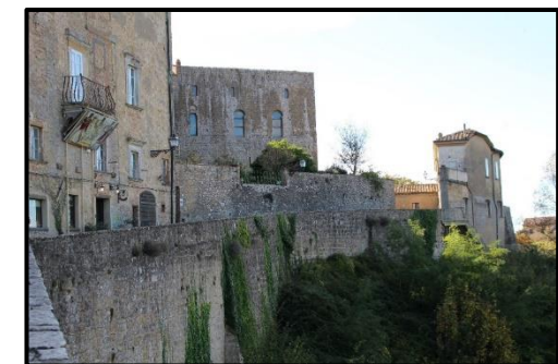
Fig. 33 – Vista della sezione 93 e parte ricostruita dopo il crollo del 2014
