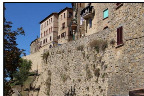
Fig. 29 – Vista della sezione 87 con a monte strada e edifici. Presenza di vegetazione.
