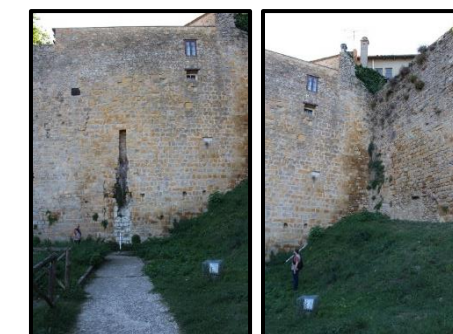
Fig. 38 – Vista della sezione 15. Presenza di edificio che ha inglobato parte della sezione e dreni. Dettaglio angolo 14-15 con edifici e vegetazione.
