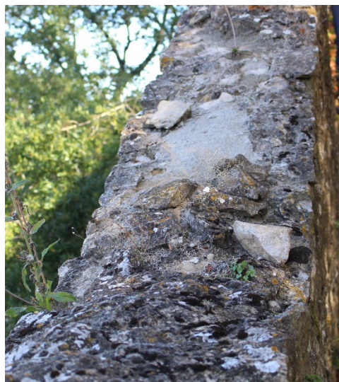
Figura 11: Dettaglio su altra sezione di sommità del parapetto (sezione 60-61).
