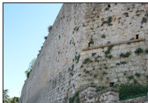
Fig.2: Vista della sezione 4 e presenza di vegetazione
