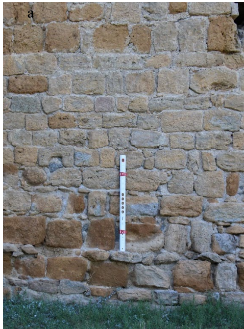
Figura 13: A sinistra particolare della sezione 13-14, ben evidente la presenza di blocchi squadrate di “panchina”; a destra particolare della sezione 5-6 con evidente presenza di umidità e vegetazione (livella lunga un metro).
