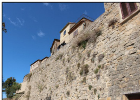
Fig.2: Vista della sezione 87 e presenza di vegetazione
