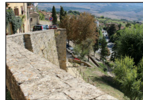
Fig.8: Parapetto sezione 92-93 a monte presenza di strada asfaltata
