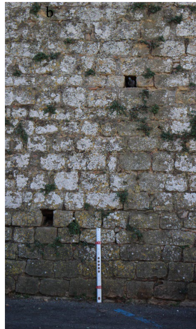
Figura 13: A sinistra particolare della sezione 13-14, ben evidente la presenza di blocchi squadrate di “panchina”; a destra particolare della sezione 5-6 con evidente presenza di umidità e vegetazione (livella lunga un metro).
