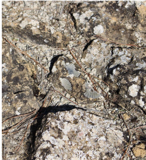
Figura 12: Presenza di conchiglie nella muratura. Foto scattata sulla sommità della sezione 48-49.
