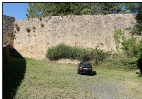
Fig.2:Foto che mostra vasta presenza di vegetazione nella sezione 48-49
