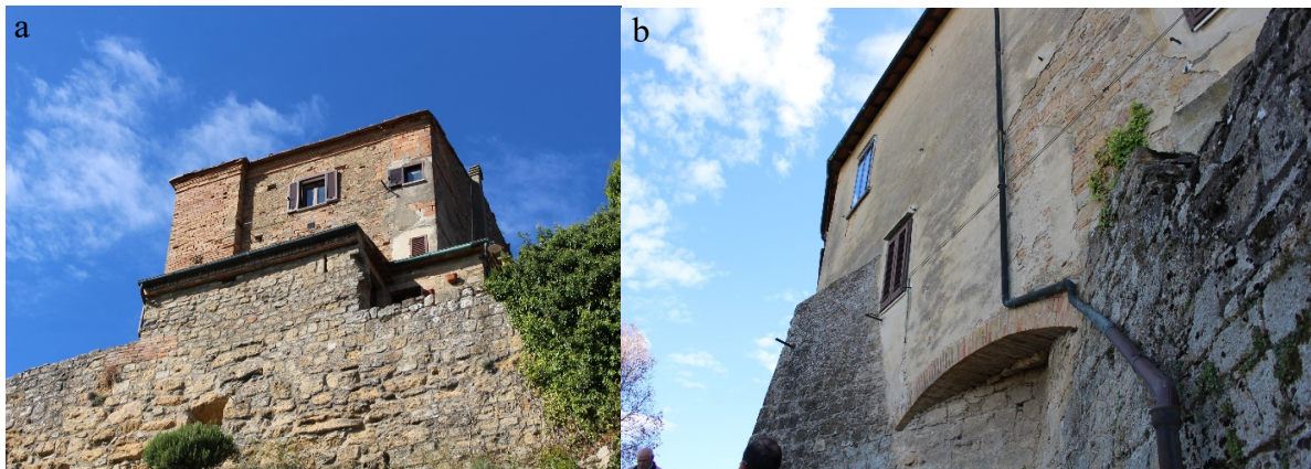
Figura 16: A sinistra, sezione 71-73; a destra, sezione 18-19. In entrambi i casi si nota la presenza di un edificio che ha inglobato parte della cinta muraria).
