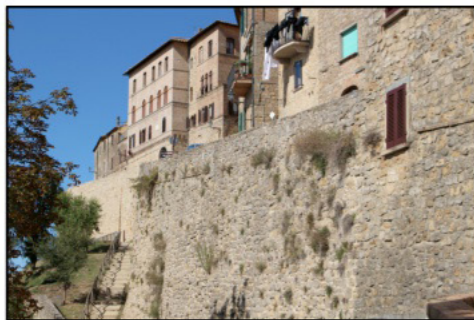
Fig.1: Vista della sezione 87 con a monte strada e edifici
